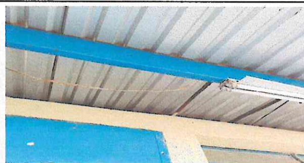
Foto 6: Cableado eléctrico y lámparas en mal estado.
